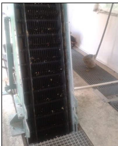
Obrázek 19 Jemné česle strojně stírané – ČOV Rudná (9800 EO)
