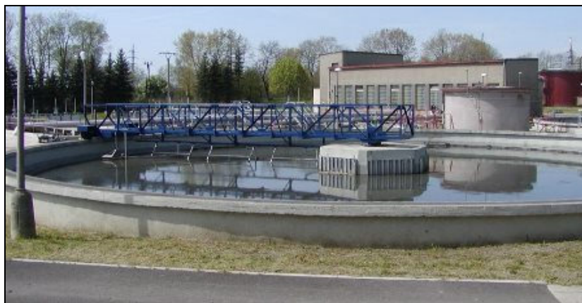
Obrázek 22 Kruhová usazovací nádrž s vertikálním průtokem a s lapákem plovoucích nečistot
