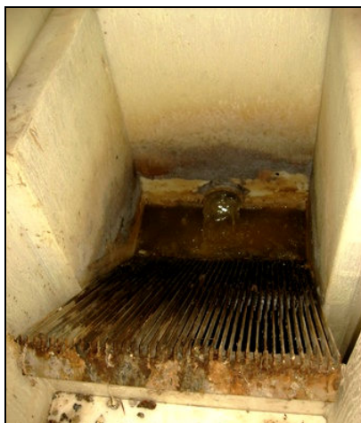
Obrázek 18 Hrubé česle ručně stírané – ČOV Němčice (500 EO)
