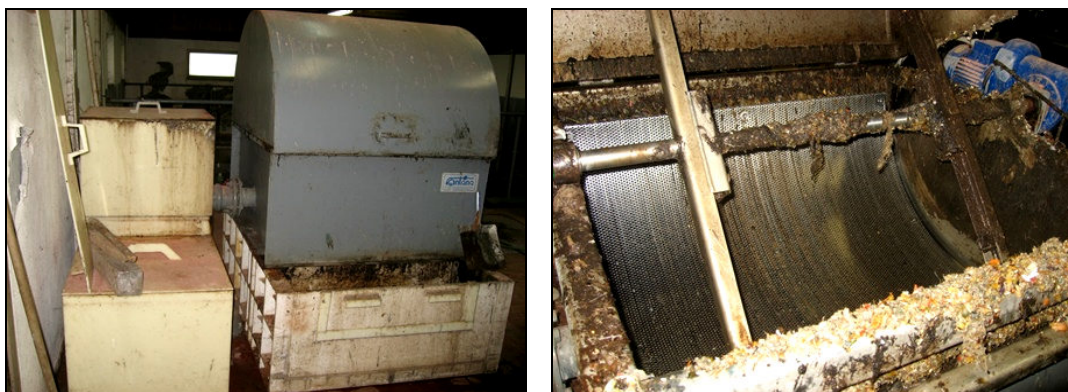
Obrázek 49, 50 Strojně stírané válcové síto – ČOV Vyžlovka (cca 1000 EO)
