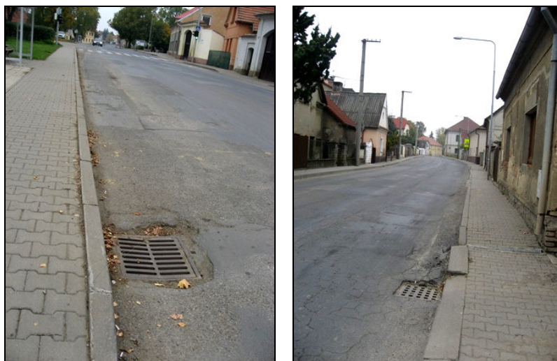
Obrázek 42, 43 Zaústění srážkových vod do dešťové kanalizace v obci Úhonice
